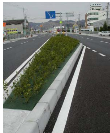
【端部折込による施工】
